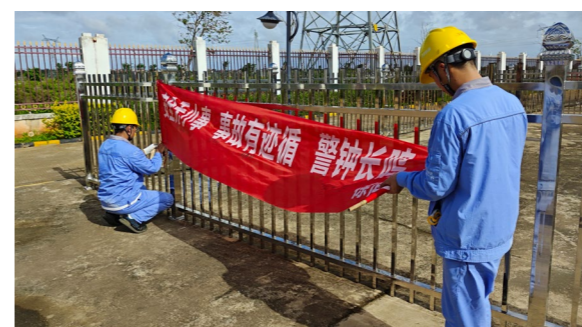
拆除易吹飛條幅
