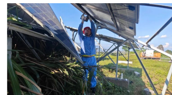
颱風後緊急搶修
