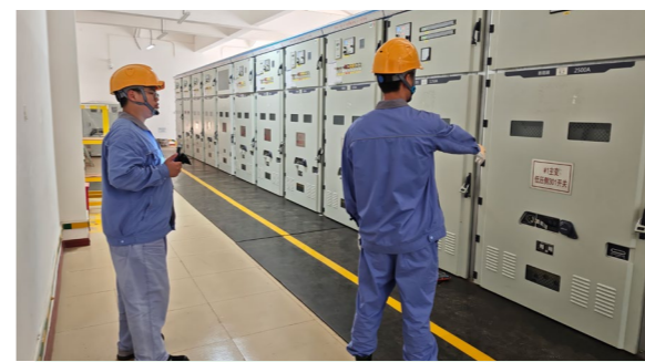
颱風前模擬現場遭受惡劣氣候倒閘操作
